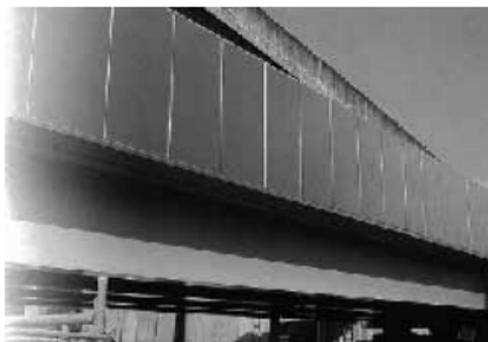
エスフォームは、工場であらかじめ製作した鋼製パネルを埋設型枠として壁高欄・地覆の外側に設置し、現場でコンクリートを打ち込んで壁高欄・地覆を製作する新しい鋼製型枠です。鋼・コンクリート合成床版、鋼床版橋の壁高欄・地覆用鋼製型枠として利用できます。また、パネルブリッジでは標準品として採用しています。
