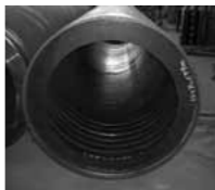
コンクリート打設前
