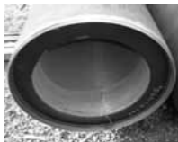
コンクリート打設後
