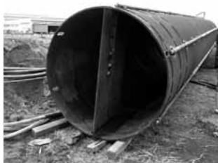
鋼管内面リブプレートの設置例
