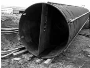
鋼管内面リブプレートの設置例
