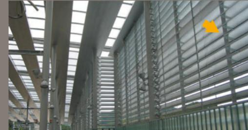
▲ 隔音百叶墙板 (车站建筑物)
