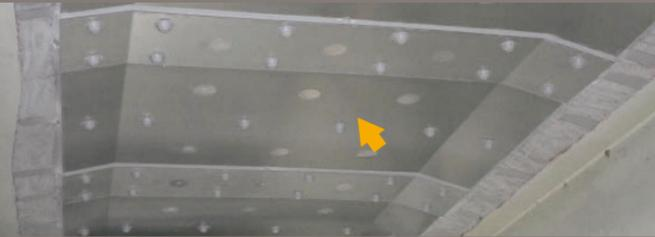
▲ 桥梁加固板 (钢板接合施工法)
