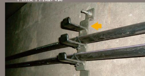
▲ 电缆管线支撑构件
