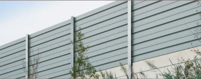
▲ 遮音壁 (ZPG 処理)
