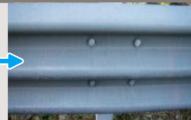
施工後5年経過しても表面に赤錆発生は認められません。
