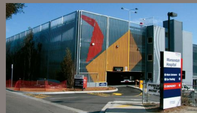
▲ 自走式立体駐車場 (全体)
