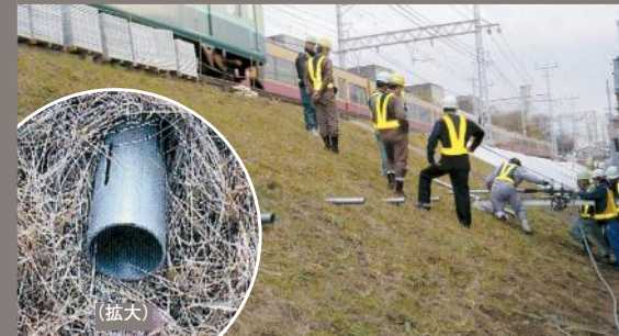
▲ 排水補強パイプ
