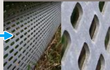
施工後10年経過しても表面、端面に赤錆発生は認められません。
