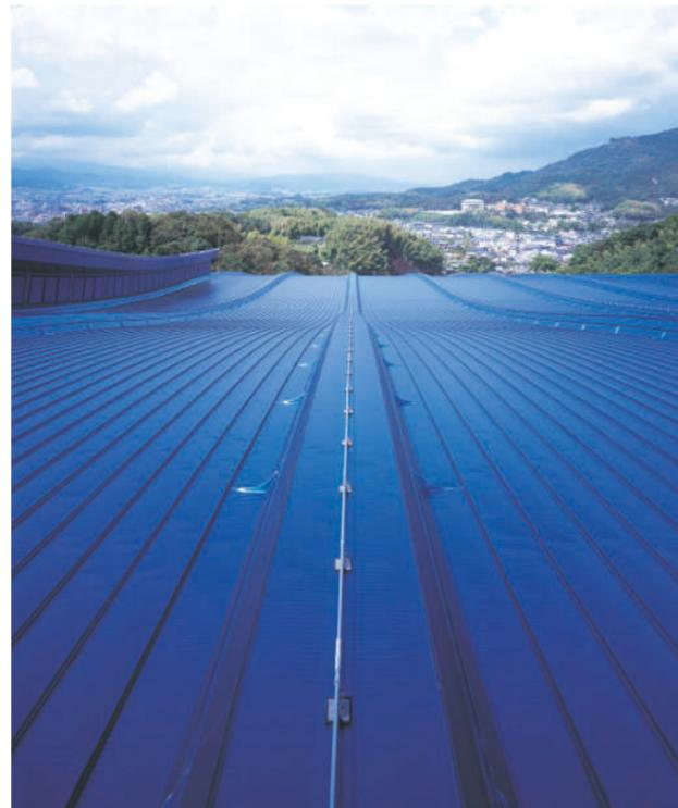
带波浪边⇒轧制成形(带凸缘)⇒接缝焊接
