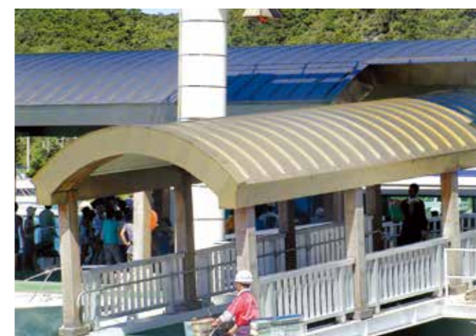
2002年竣工(2004年撮影) [薄い膜厚の金色を維持(変色しにくい材料)]
