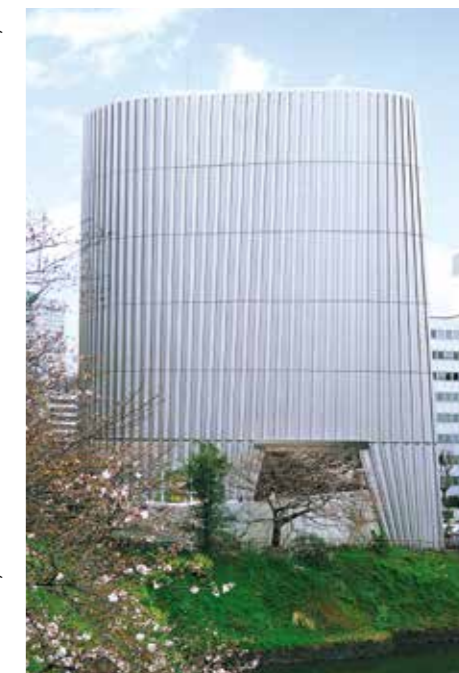
昭和館 表面：アルミナブラスト (AD09) 面積：4,200m 2 重量：56tons 竣工：1998年
