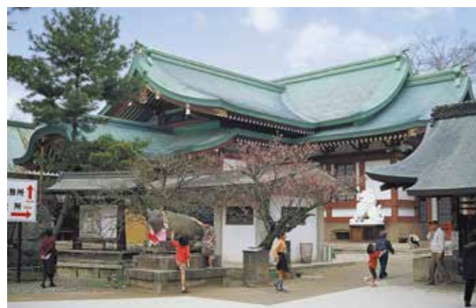
北野天満宮／宝物殿 表 面：アルミナプラスト(AD09)、発色：緑青 面 積：1,000m 2 重 量：4tons 竣 工：1998年
