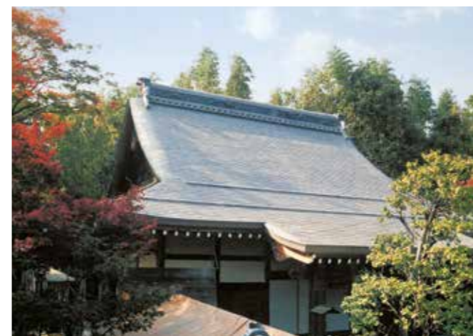
光悦寺/本堂 表面：アルミナブラスト (AD03) 面積：700m 2 重量：1.2tons 竣工：1997年
