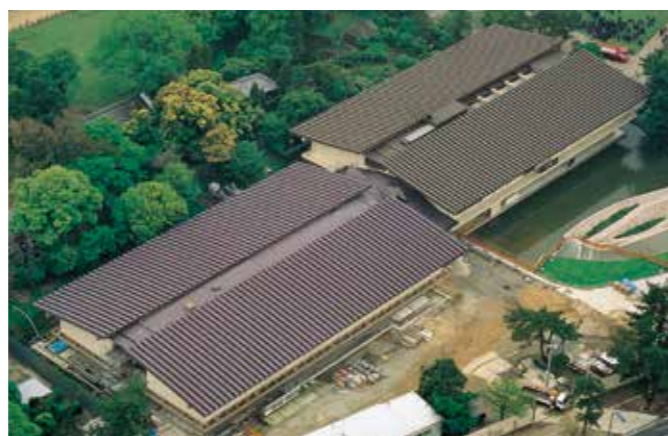
奈良国立博物館(第2新館) 表 面：アルミナプラスト(AD03)、発色：コルテン 面 積：6,000m 2 重 量：12tons 竣 工：1998年
