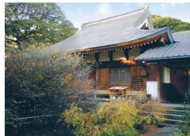
大中寺 表面：アルミナブラスト (AD03) 面積：660m 2 重量：1.2tons 竣工：2006年
