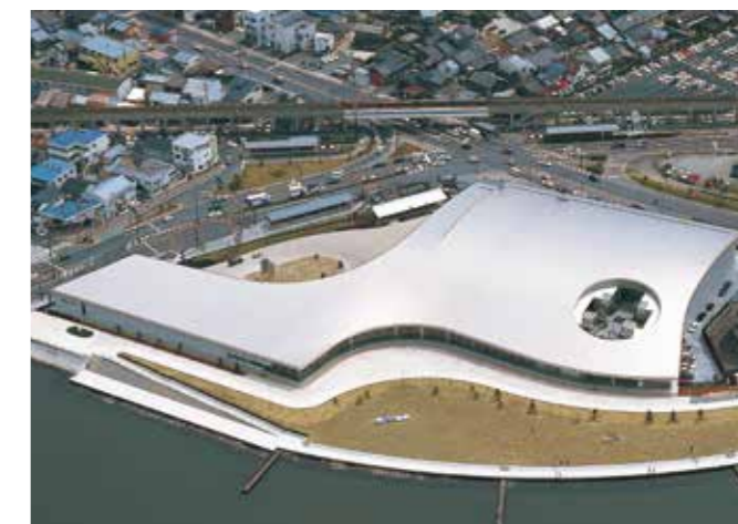
島根県立美術館 表面：酸洗ダル(VP20) 面積：10,000m 2 重量：60tons 竣工：1998年
