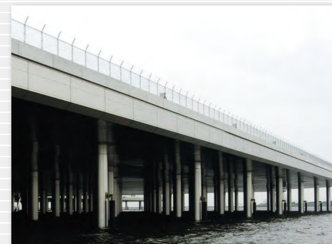
羽田空港 D 滑走路 栈橋部
