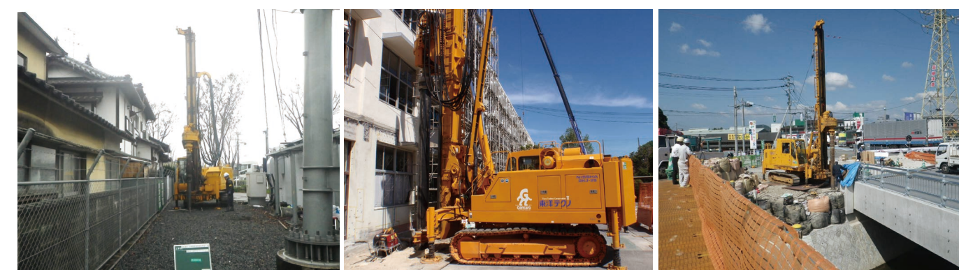
通信鉄塔基礎工事
