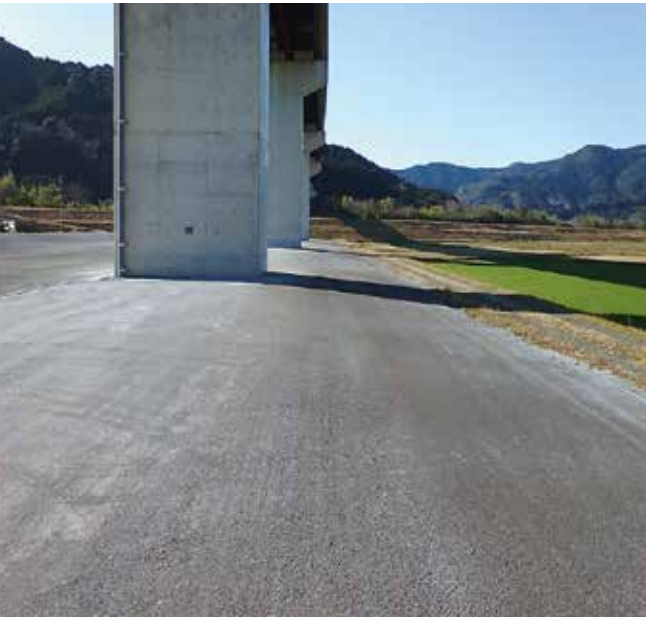
写真 8：高架下防草対策
