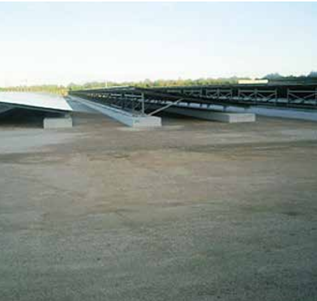
写真 7：ソーラー発電所防草対策
