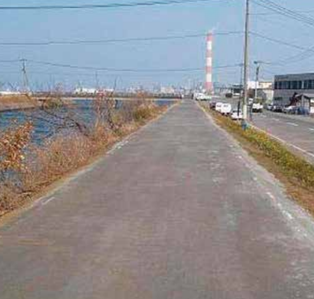
写真 4：河川護岸天端管理道路
