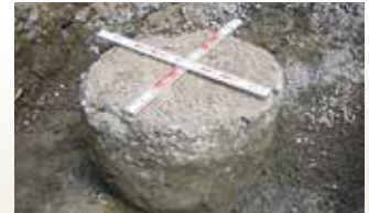
SCP杭の打設状況
