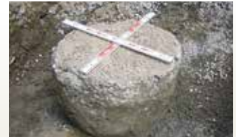
SCP杭の打設状況
