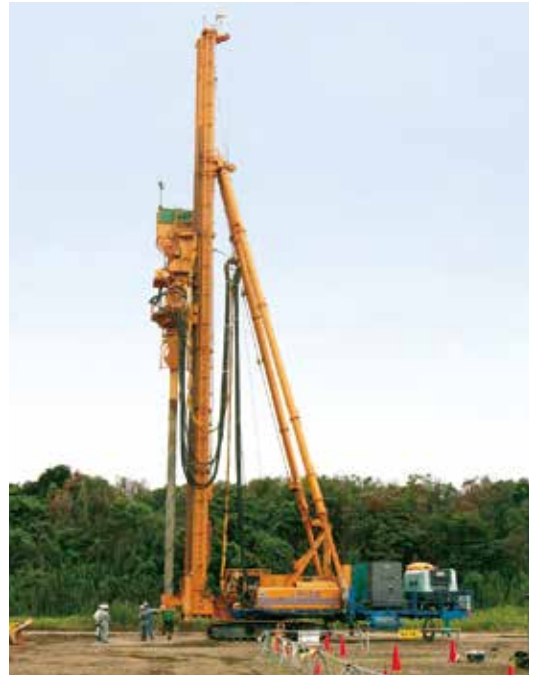
地盤改良施工状況(SAVEコンポーザー)
