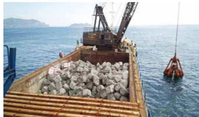
釜石湾口防波堤工事(フロンティアロック)
