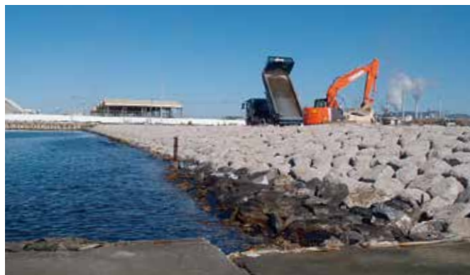
雲雀野北埠頭荷捌地災害復旧工事(フロンティアロック)
