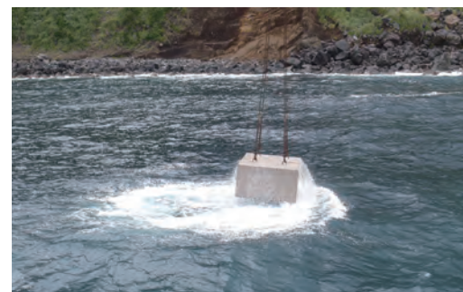
ビバリーブロックの設置状況
