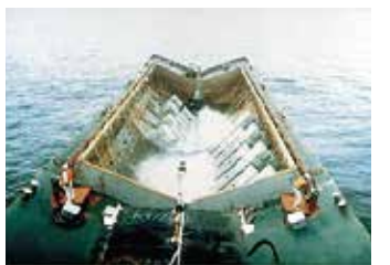
底開バージ船での投入状況
