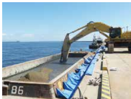
バックホウ混合工法
