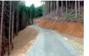
林道(作業道)施工後
