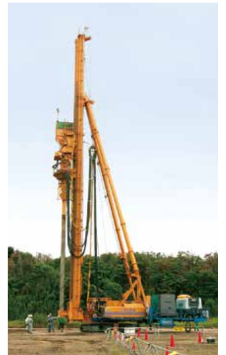
地盤改良施工状況(SAVEコンポーザー)
