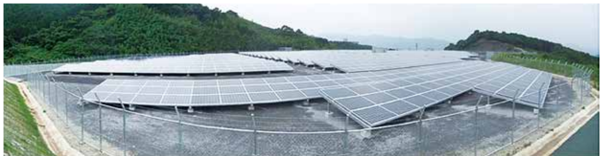
ソーラー発電所防草対策用施工例
