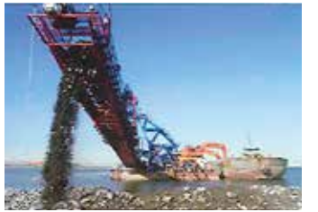
作業船による揚土状況
