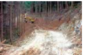
林道(作業道)施工前
