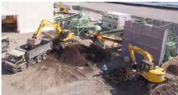
カルスピン工法プラント全景
