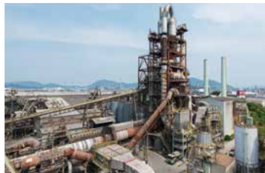
セメント製造設備
