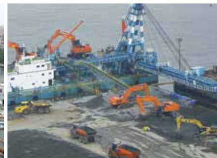
落下混合工法
