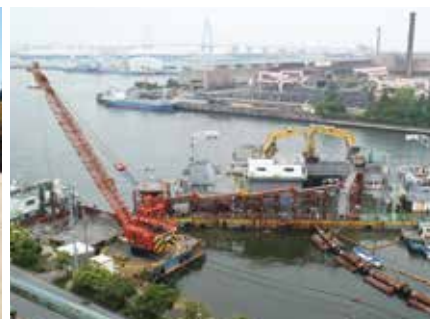
管中混合工法
