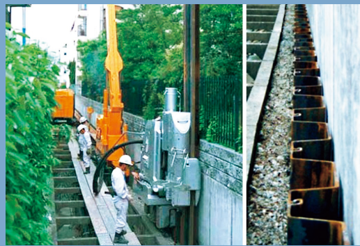
省スペース対応工法(ゼロクリアランス工法)
