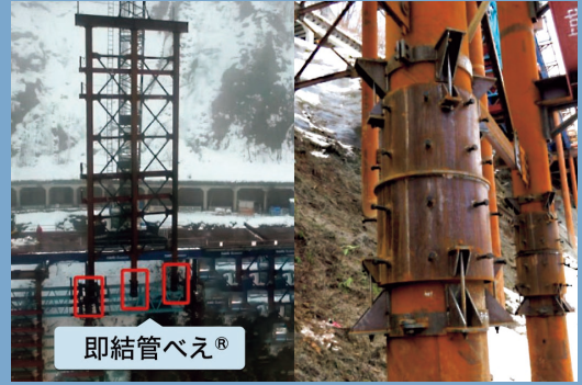
システム仮設工法(勘トリー®工法、即結管べえ®) (NETIS登録番号 KK-220022-A、特許第6737740号 他)
