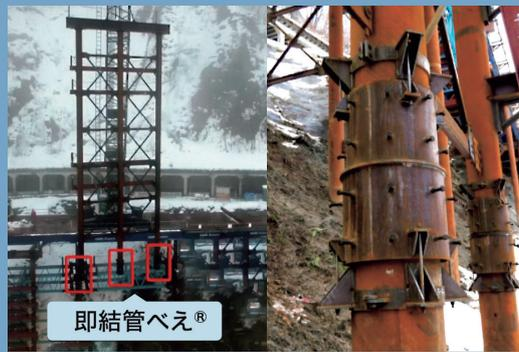
システム仮設工法(勘トリー®工法、即結管べえ®)
