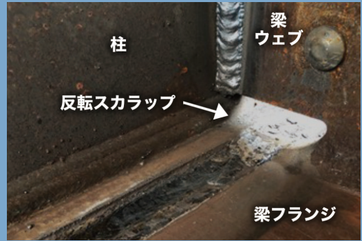
梁端ストレート工法 (BCJ評定-ST0311-01)
