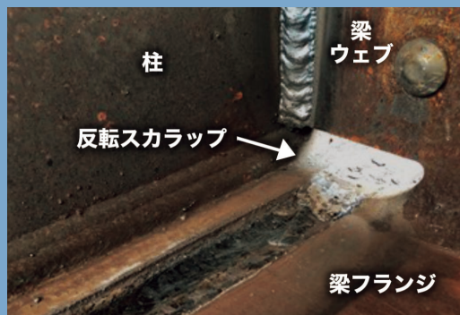
梁端ストレート工法
