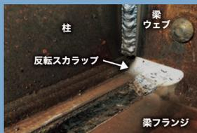
反転スカラップを適用することで梁端の早期破断が防止できます。
