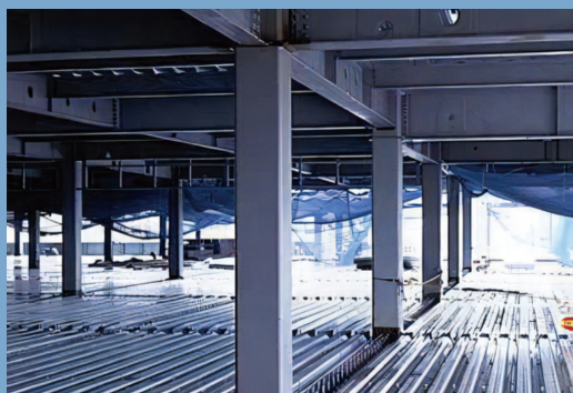
コラム (冷間成形角形鋼管柱)
