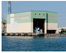
写真：東日本製鉄所/全天候/ベース建屋
