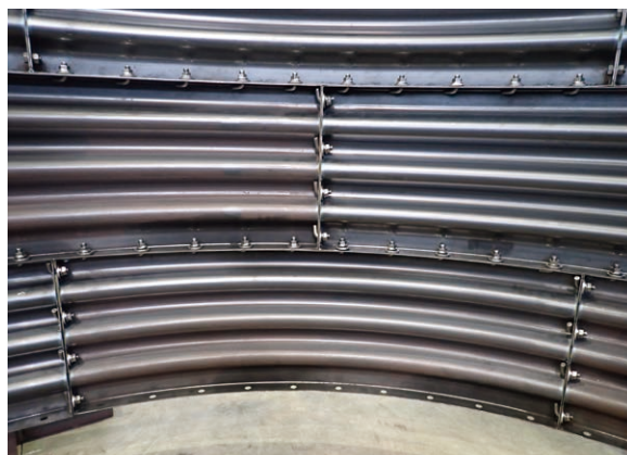
エルボルト施工状況
