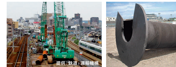
【施工状況(全周回転式杭打機)】
