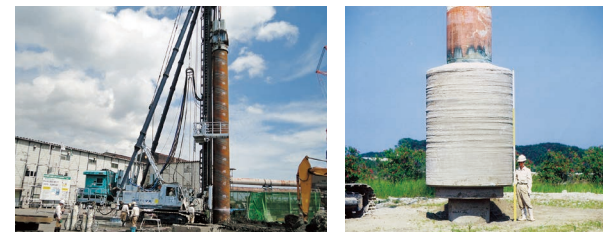
【施工状況(三点式杭打機)】
