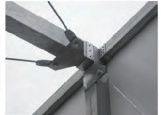
▼パネルを耐力壁として活用し鉄骨重量削減
