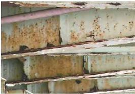
橋梁の塗装剥離 (塩害が激しい環境)
