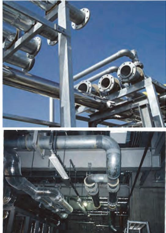
**100A以下：SW鋼管（熱間仕上電縫管）SGP E-H、STPG E-H**
