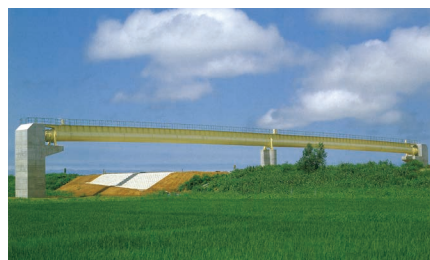
フランジ補剛式水管橋
