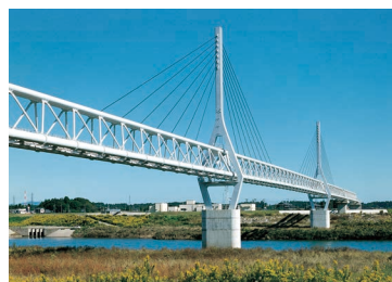
斜張補剛式水管橋
