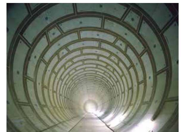
<NMセグメント™施工事例>
