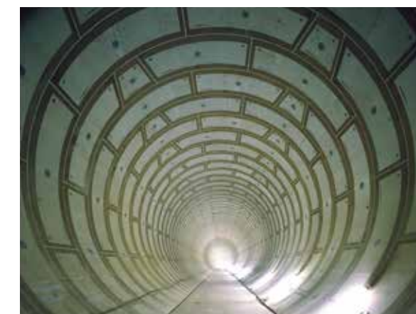
<NMセグメント™施工事例>
