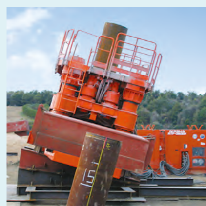
斜杭施工状況
