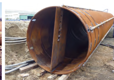
内側リブプレートの設置例
