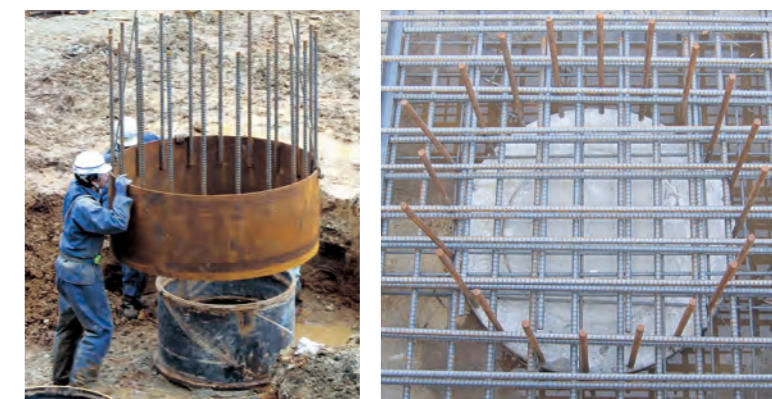
拡頭リング設置状況
