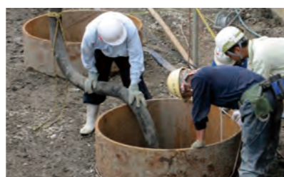
コンクリート打設状況
