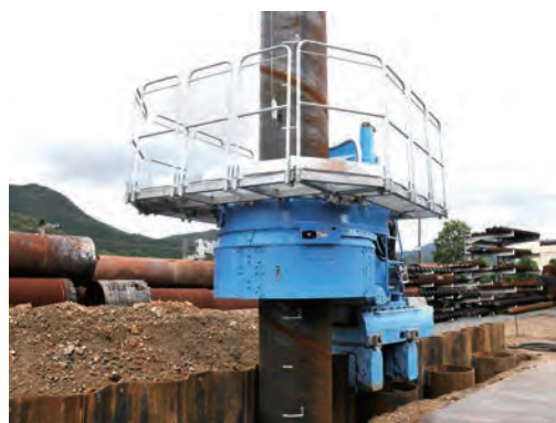
鋼管杭施工状況
