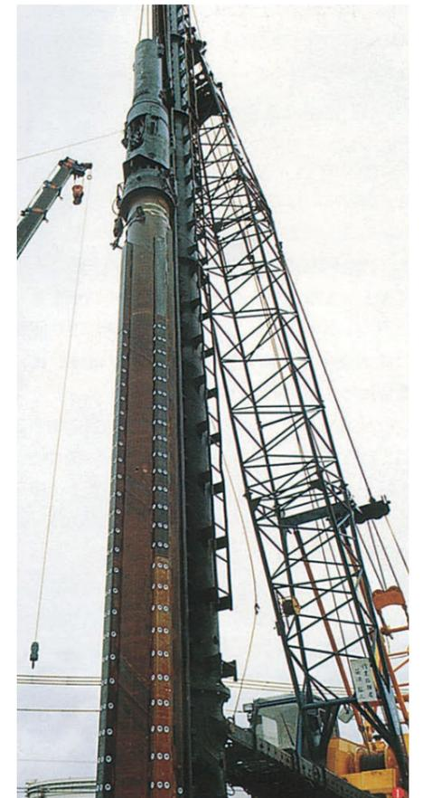
①東京湾埋立地東扇島で行われた排水機能付き鋼管杭タイプの打ち込み状況。②工事現場で待機する「NSハイドレールパイル(鋼矢板タイプ)」。③打ち込みは振動も騒音もなく、スムーズに進む。④クレーンで吊り下げられたパイルはまたたく間に打ち込み機にセットされる。⑤沈砂池の周辺に整然と打ち込まれたパイル。
