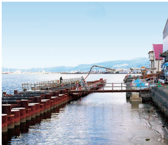
H港中央ふ頭地区岸壁改良工事
