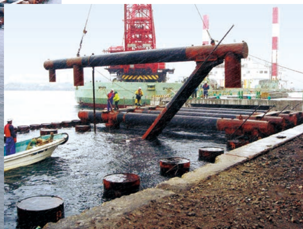
M港-8m岸壁
