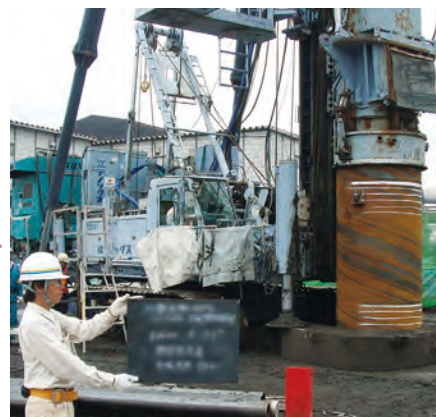
杭圧入沈設完了
