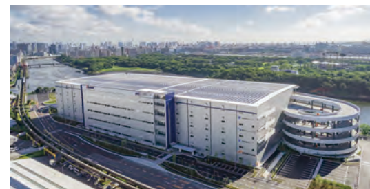
■ 京浜トラックターミナル(施工:2014年、2017年)
