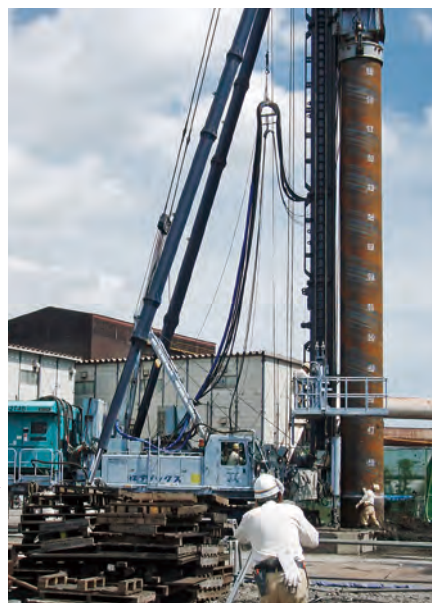
杭鉛直精度確認および圧入沈設状況
