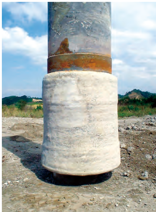
砂層での先端根固め拡大球根形成例
