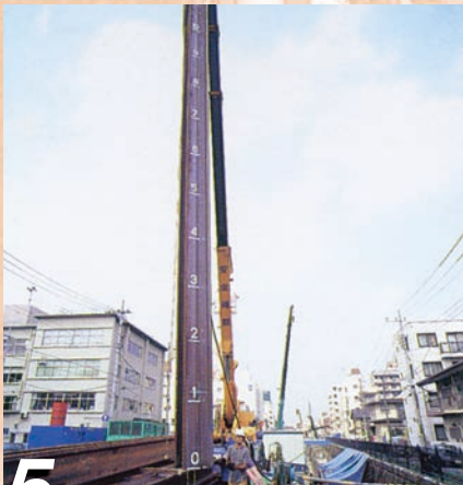
5 部材吊り上げ
