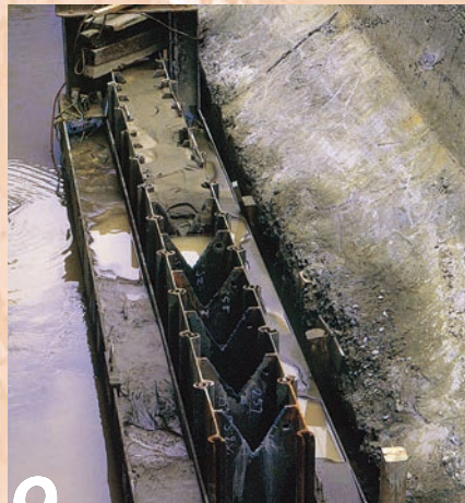
9 部材打込み完了
