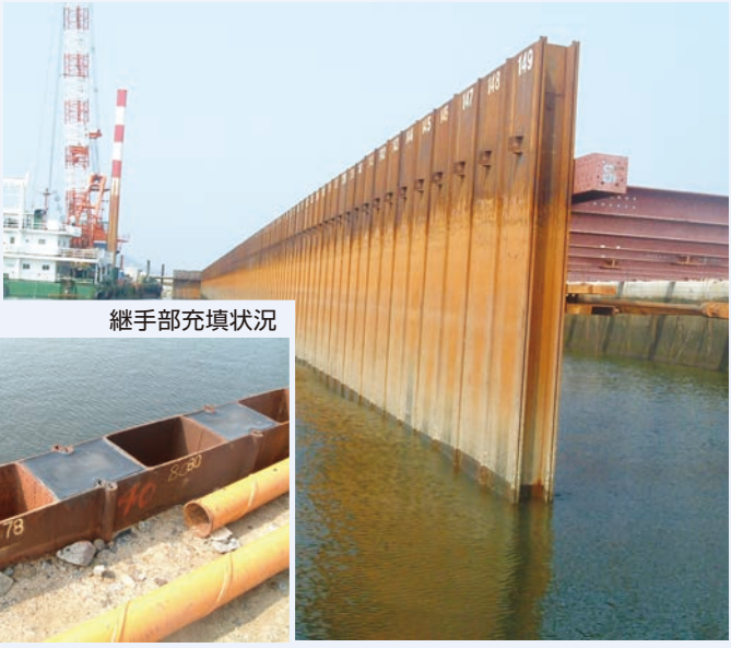
実物試験による止水性確認状況 BX400、打設長13m、GL-10.0mまで継手閉合部内部を排土・清掃 地下水位 GL-4.0m
