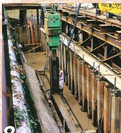
8 部材打込み完了前
