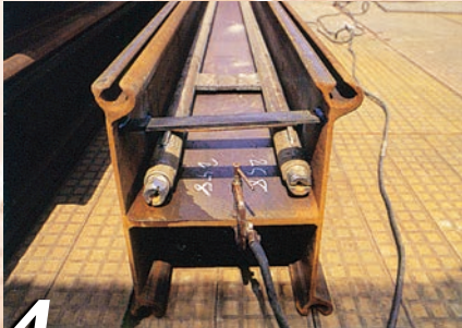
4 ウォータージェット送水管取付け
