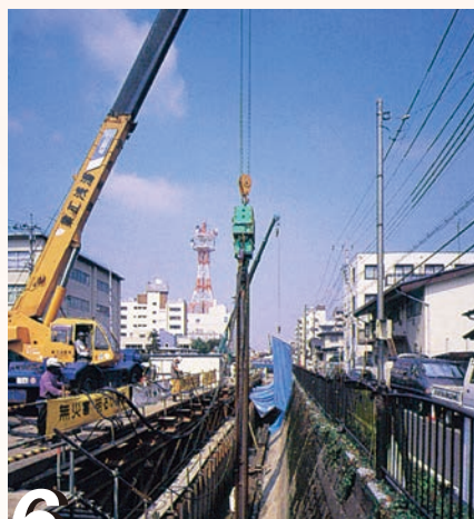
6 バイプロハンマ取付け
