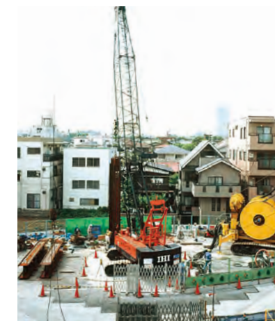
新駒沢幹線立坑工事 GH 発注者：東京都下水道局
