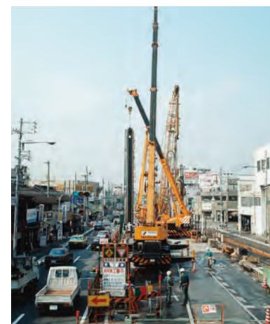
淀川共同溝海老江立坑工事 GH 発注者：国交省近畿地方整備局大阪国道事務所
