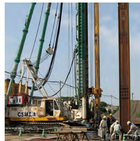
熱処理用電気炉ピット築造工事 SC 発注者：日本鑄鍛鋼株式会社
