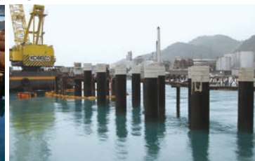
Tháp máy bốc xếp ở phần Cầu cảng mới của Cảng Fushiki-Toyama
