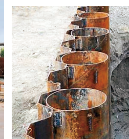
Về cọc ván thép kiểu "cái mũ", vui lòng xem thêm tài liệu "Cọc ván thép" của chúng tôi
