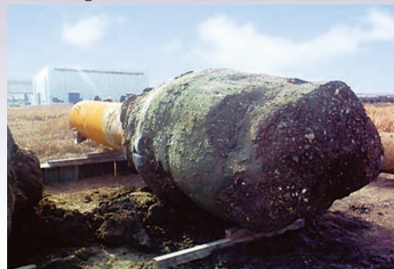
Phần bầu mở rộng bảo vệ mũi cọc khi sử dụng bản sườn thép gắn bên ngoài
