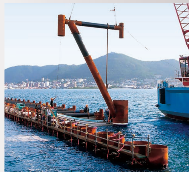
Công tác cải tạo cho kè tường bến tàu tại khu vực bến tàu trung tâm của Cảng H
