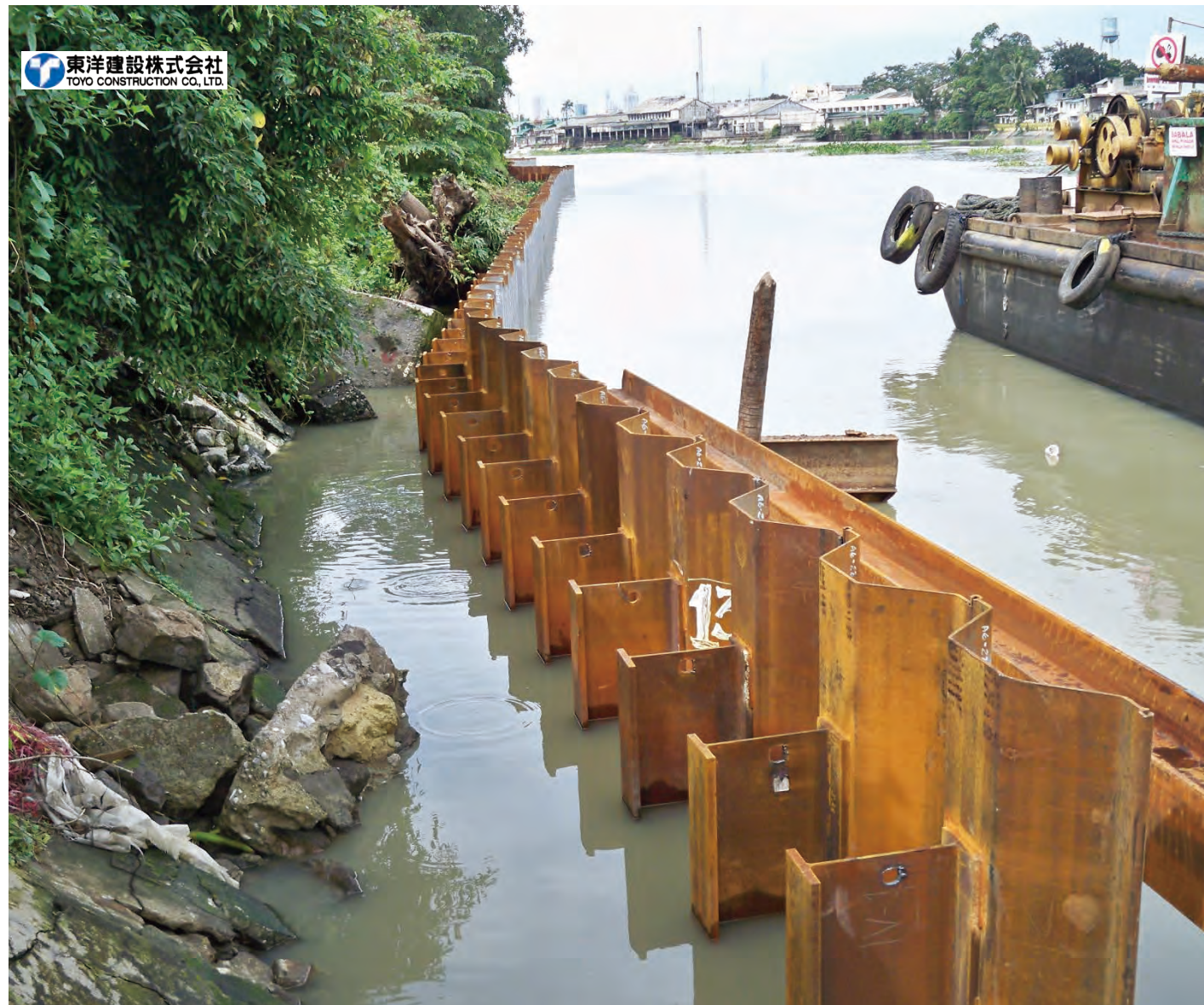
Dự án cải tạo kênh Pasig, Marikina giai đoạn 3 tại Philippin sử dụng tổ hợp cọc ván thép kiểu mũ + thép hình H
