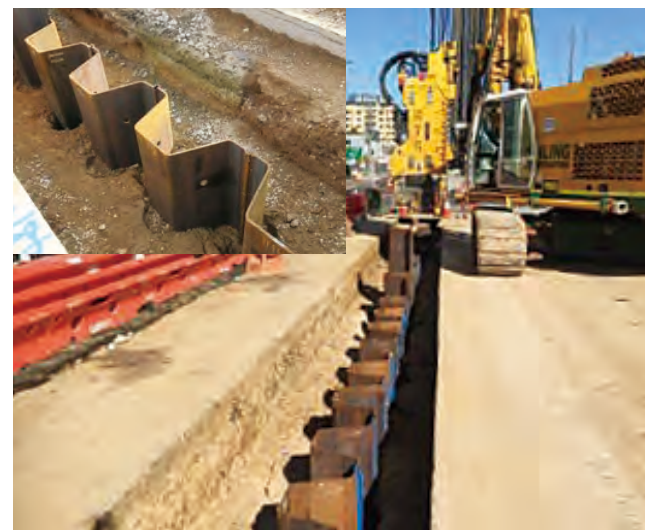
Dự án O-Bahn City Access tại Úc sử dụng cọc ván thép kiểu mũ
