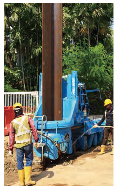
Dự án tại Singapore sử dụng cọc thép kiểu mũ
