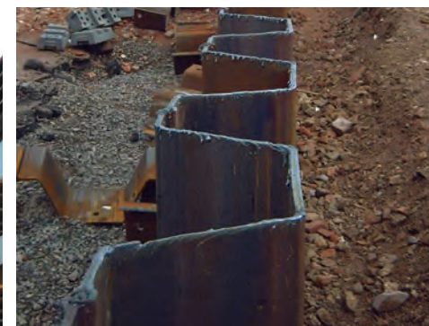
Sau khi thi công
