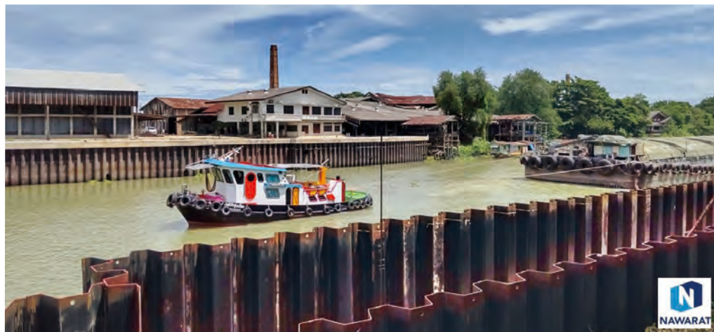
Dự án kè sông tại Thái Lan sử dụng cọc ván thép kiểu mũ
