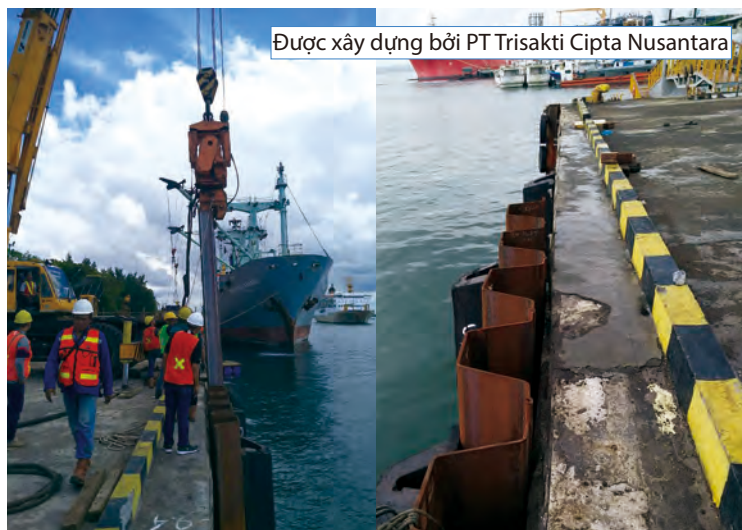
Dự án tường bảo vệ bến cảng bê tông tại Indonesia sử dụng cọc ván thép kiểu mũ
