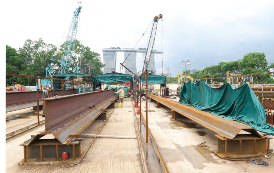
Dự án đường sắt đô thị Singapore sử dụng cọc ván thép kiểu mũ
