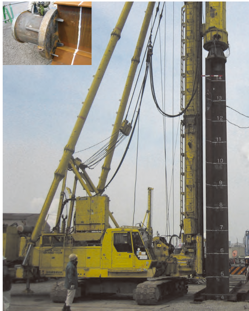
Ví dụ về việc thi công cọc sử dụng búa thủy lực
