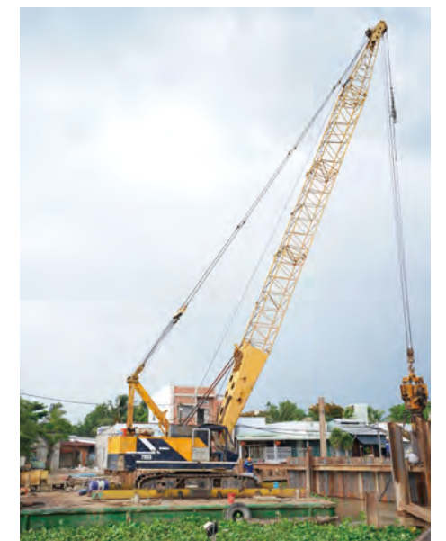
Dự án cổng ngăn triều Đẩu Sấu tại Cần Thơ – Việt Nam sử dụng cọc ván thép kiểu mũ cho tường chống thấm.
