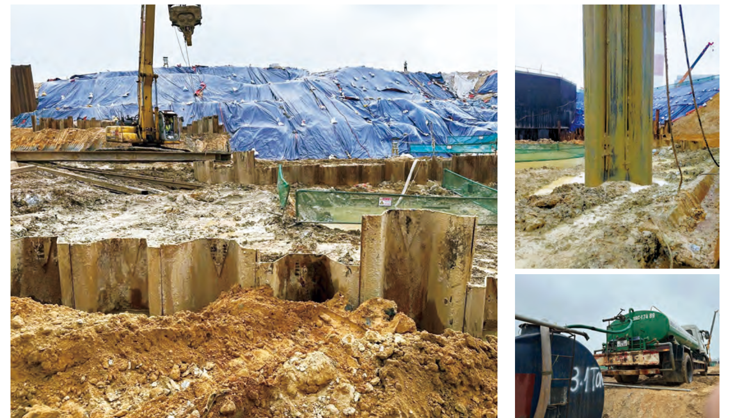
Dự án xây dựng nhà máy Nhiệt điện Vũng Áng 2 tại Hà Tĩnh – Việt Nam sử dụng cọc ván thép kiểu mũ làm hệ cử tạm
