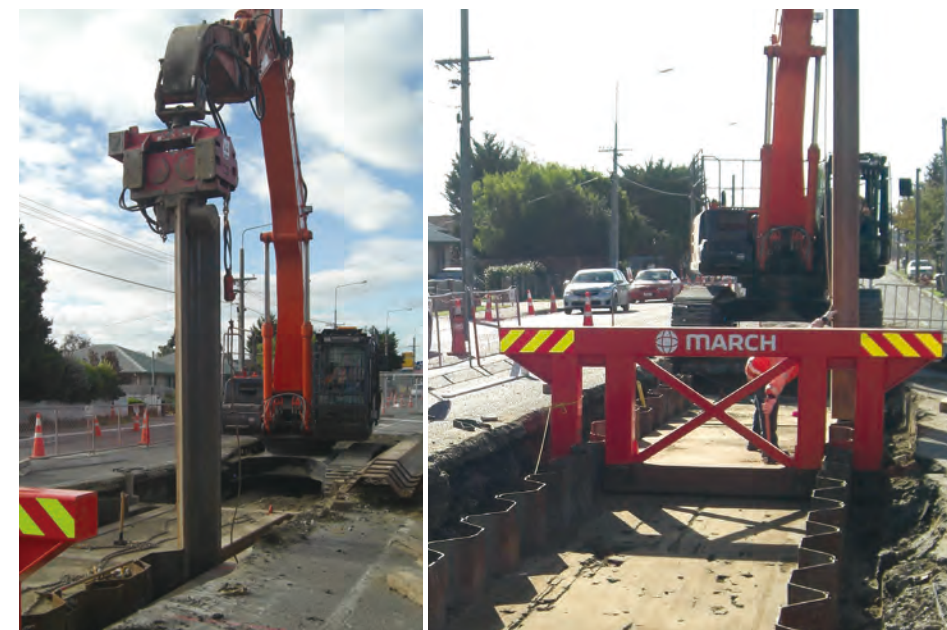
Dự án trong đô thị của New Zealand sử dụng cọc ván thép kiểu mũ
