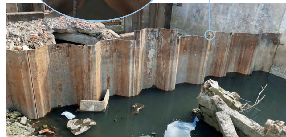
Dự án cổng ngăn triều Đẩu Sấu tại Cần Thơ – Việt Nam sử dụng cọc ván thép kiểu mũ cho tường chống thấm.
