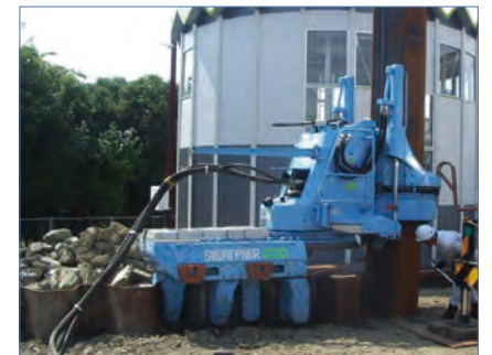
Ví dụ về trường hợp thử nghiệm tái sử dụng khi dùng phương pháp nén-ép
