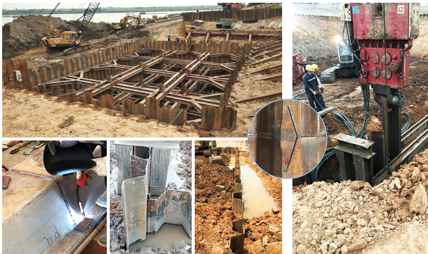
Dự án trạm bơm nhà máy Nước Mặt Sông Hồng tại Hà Nội – Việt Nam sử dụng cọc ván thép kiểu mũ làm hệ cử tạm
