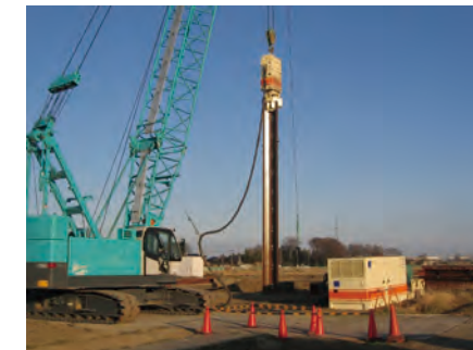
Ví dụ về trường hợp thử nghiệm tái sử dụng khi dùng búa rung
