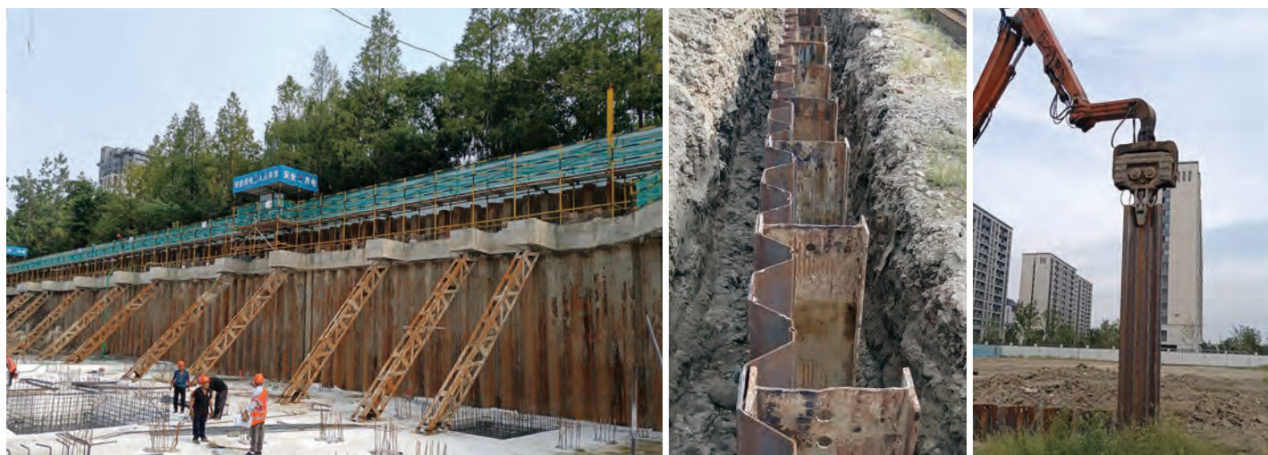
帽型 H 型嵌合式组合桩临时挡土墙工程 / 中国
