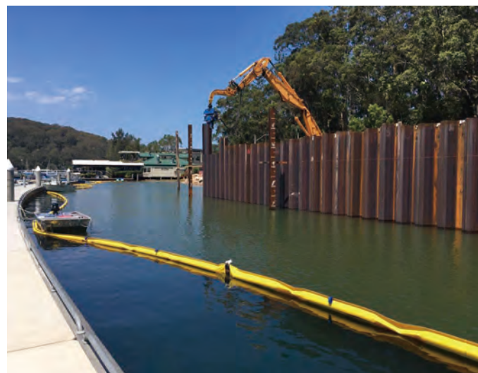
帽型钢板桩 Church Point 护岸 / 澳大利亚
