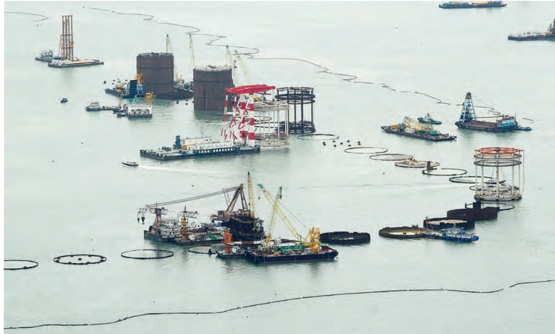
格型钢板桩（直腹式钢板桩）港珠澳大桥人工岛 / 香港
