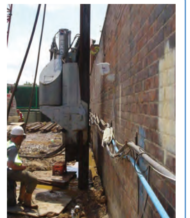
NS-SP-J型钢板桩静压打桩
