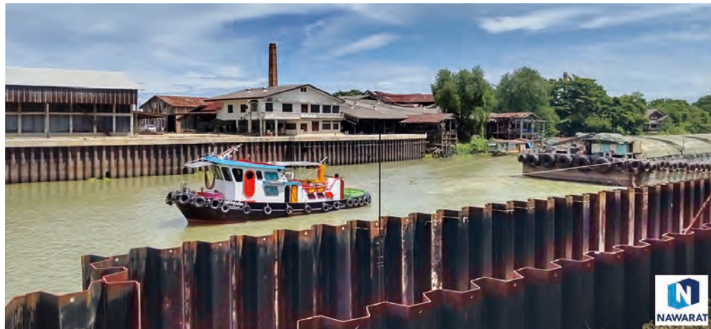
帽型钢板桩 河流护岸 / 泰国
