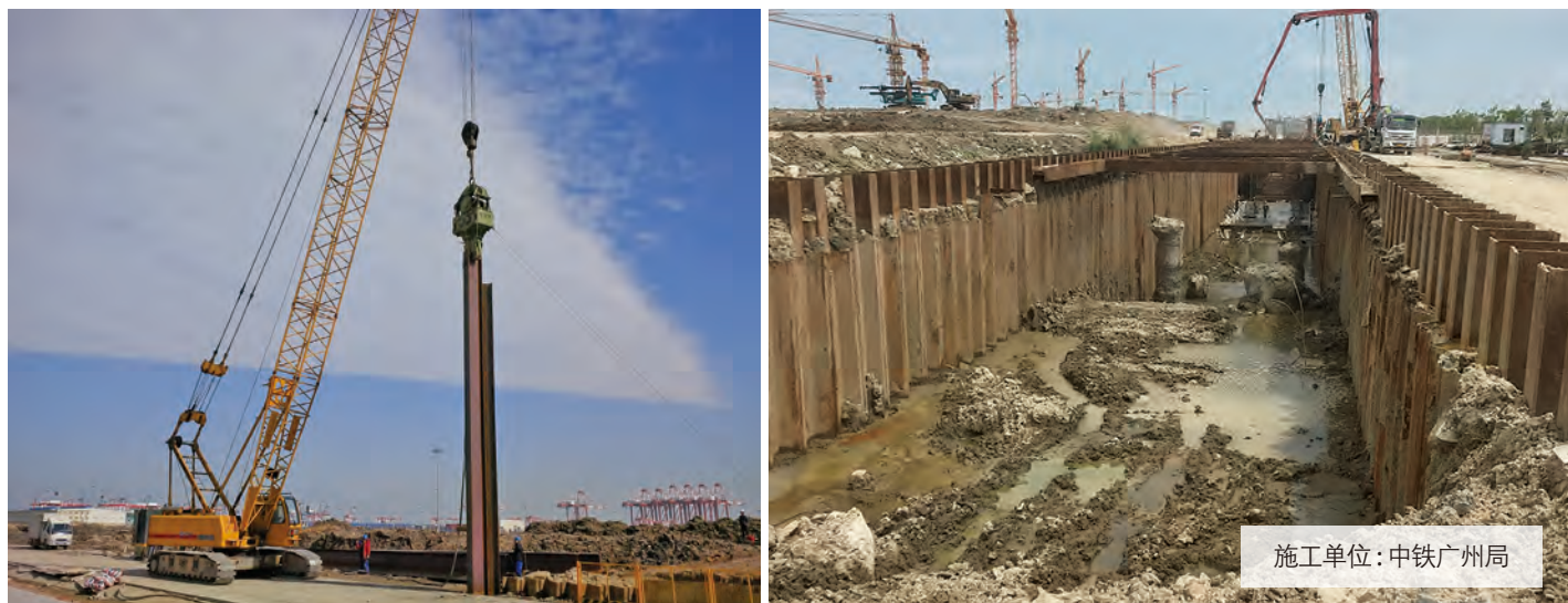
帽型 H 型组合钢板桩南沙铁路临时挡土墙工程 / 中国
