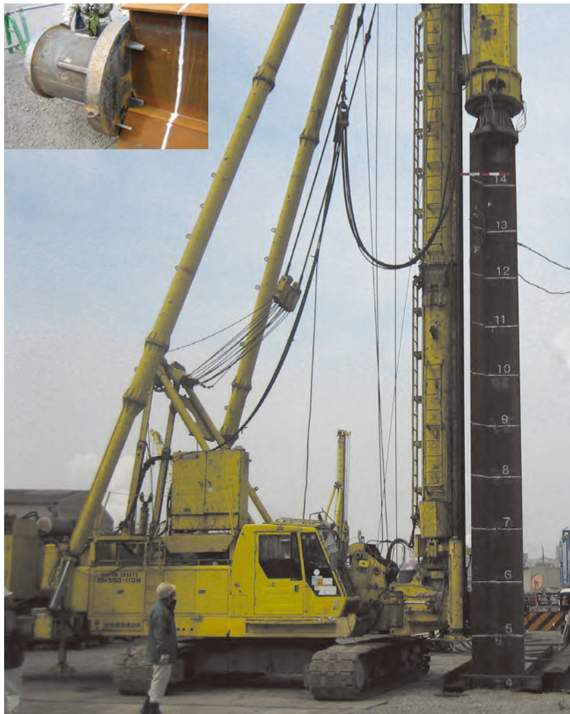
帽型H型组合钢板桩打桩
