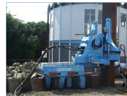
静压机重复打桩试验
