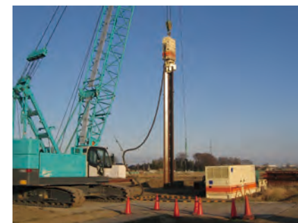
振动锤重复打桩试验
