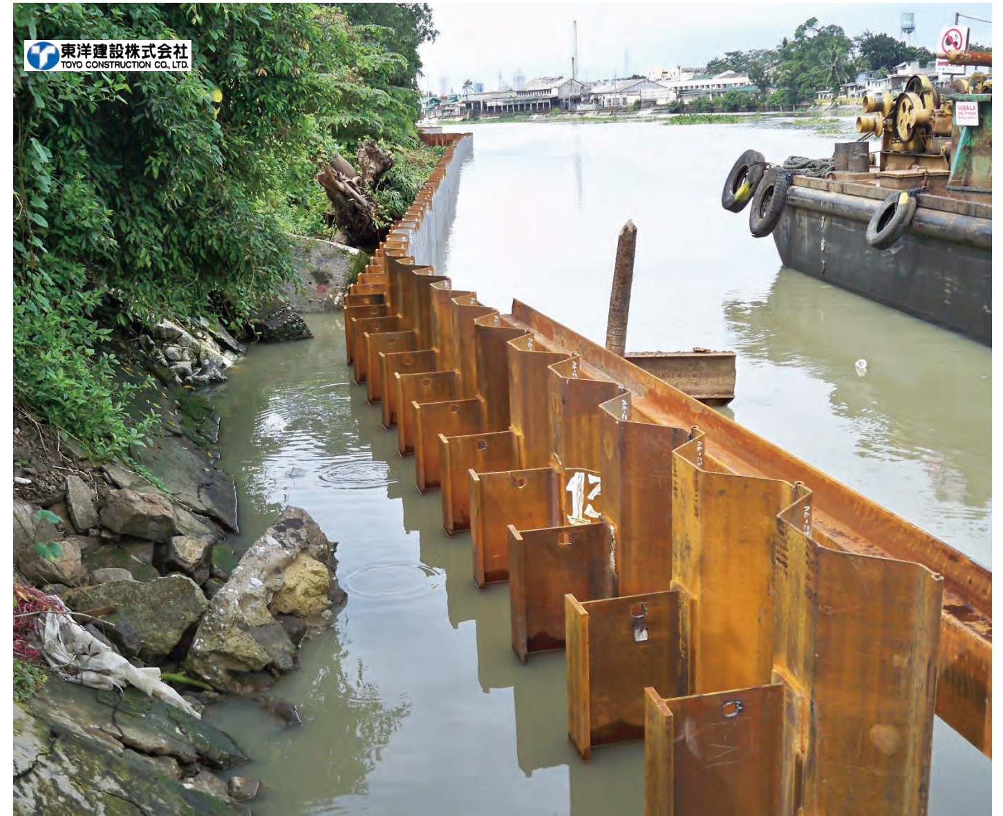
帽型 H 型组合钢板桩 Pasig-Marikina River 河道治理工程 / 菲律宾
