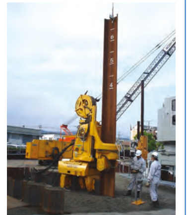
U型钢板桩静压打桩
