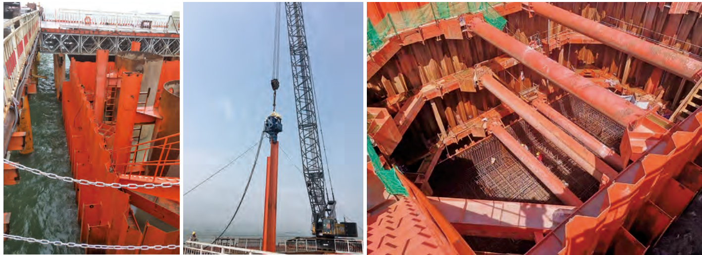
帽型 H 型组合钢板桩深中通道围堰工程 / 中国
