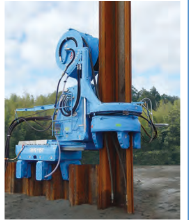
帽型钢板桩静压打桩
