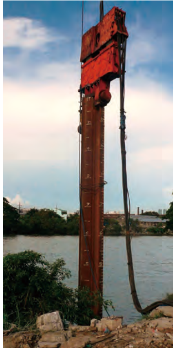
帽型H型组合钢板桩打桩
