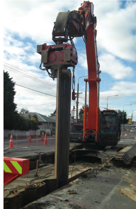
帽型钢板桩打桩
