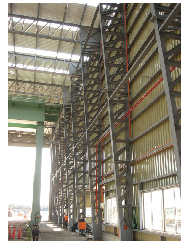
システム建築(ラチスタイプ)内観
