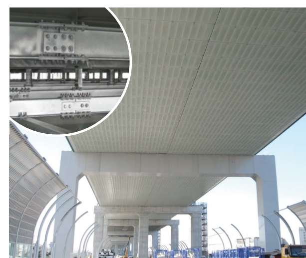
高速道路の裏面吸音板支持梁
