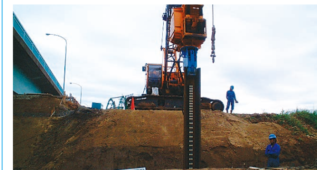
パイプロによる施工
