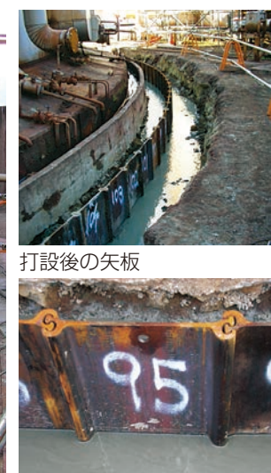
打設後の矢板 継手嵌合状態
