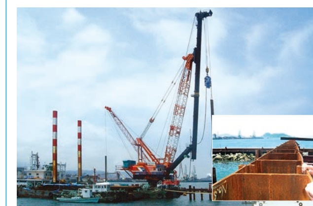
新居浜処分場(箱型鋼矢板: NS-BOX)
