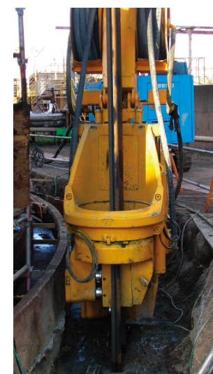
圧入機による施工
