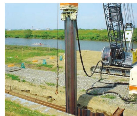
ハット形鋼矢板での施工事例
