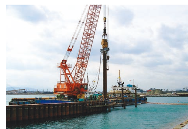
徳島粟津処分場(鋼管矢板+鋼矢板)
