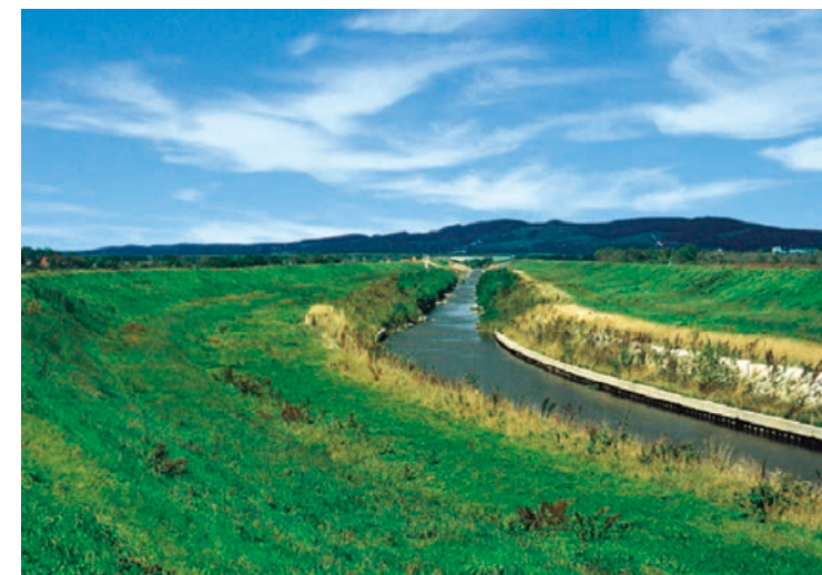
自然環境へ配慮した事例…透水性鋼矢板を使用
