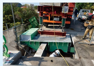
施工写真 (実績:北九州)
