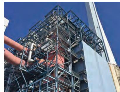
石炭火力発電所の排煙脱硫装置
