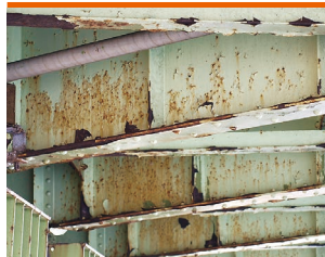
橋梁の塗装剥離 (塩害が厳しい環境)
