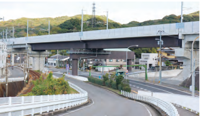
写真10-4 ①宇都架道橋 ②鉄道・運輸機構 ③長崎県 ④箱桁・橋脚 ⑤V12 ⑥さび安定化補助処理 ⑦2018(2022.12)
