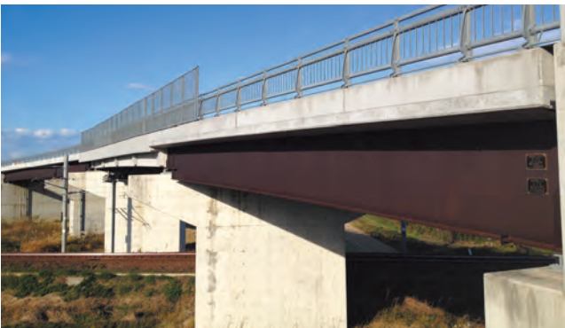
写真10-3 ①神崎跨線橋 ②大分県 ③大分県 ④鉸桁(5主) ⑤V12 ⑥裸 ⑦2010(2013.11)
