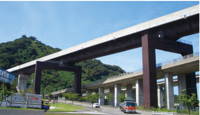
写真10-1 ①北陸新幹線北陸道架道橋 ②日本鉄道建設公団(現、鉄道・運輸機構) ③新潟県 ④箱桁・鋼管桁(4主)・橋脚 ⑤V15 ⑥さび安定化補助処理 ⑦1998(2005.9)
