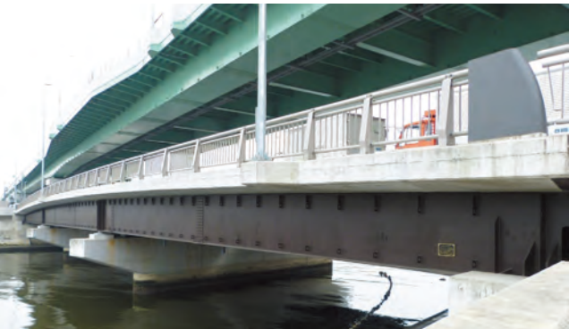
写真10-2 ①東橋 ②名古屋市 ③愛知県 ④鉸桁(5+5主) ⑤V12、V15 ⑥さび安定化補助処理 ⑦2007(2013.6)
