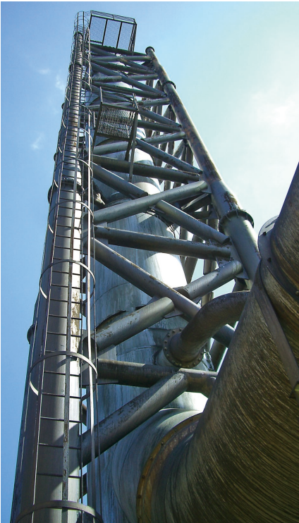
発電所の煙突
