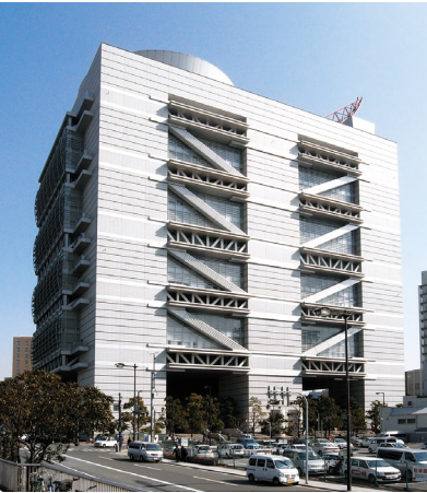
会議場（鋼製アンボンドプレース適用）
