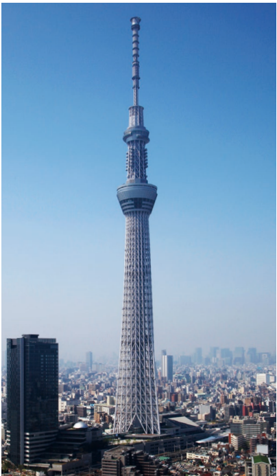
東京スカイツリー® (事業主体：東武鉄道・東武タワースカイツリー)
