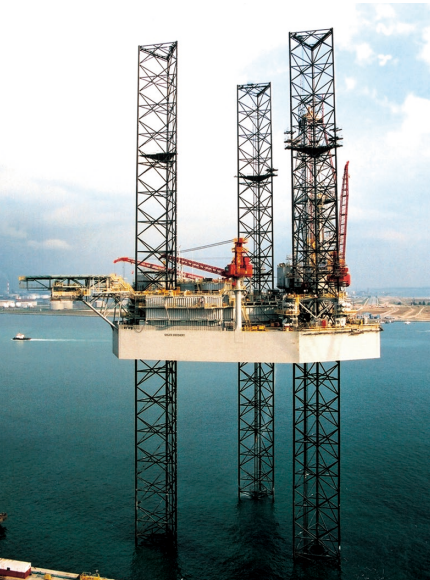
ジャッキアップリグ海洋構造物
