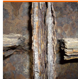
橋梁の腐食 (塩害が厳しい環境)
