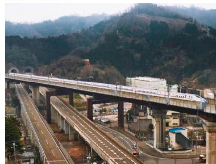
北陸新幹線北陸道架道橋 / 鉄道・運輸機構
