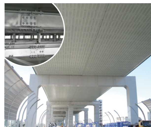
高速道路の裏面吸音板支持梁
