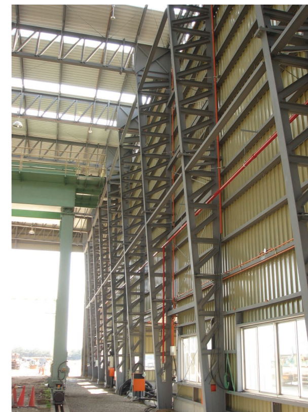
システム建築(ラチスタイプ)内観
