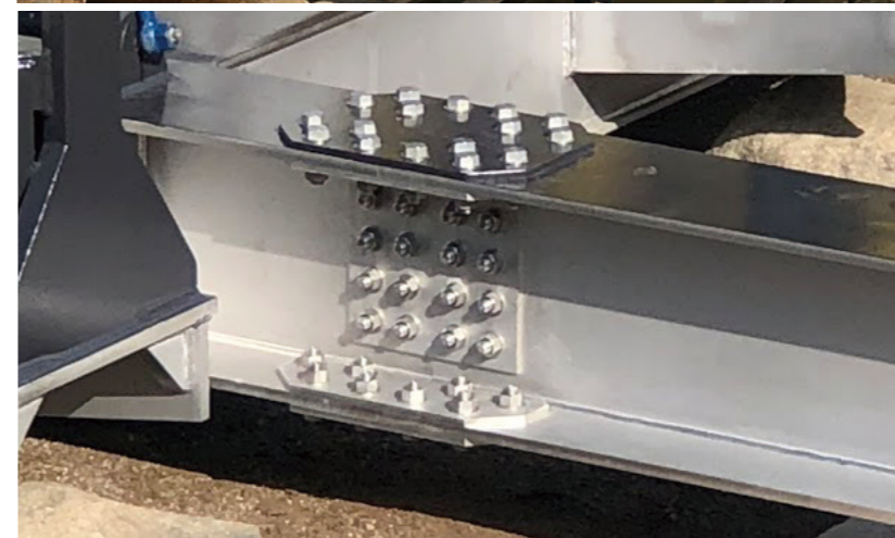
水中梁 二相ステンレス鋼 ボルト
