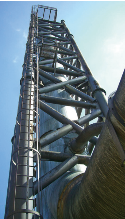
発電所の煙突
