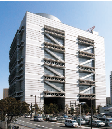
会議場（鋼製アンボンドブレース適用）
