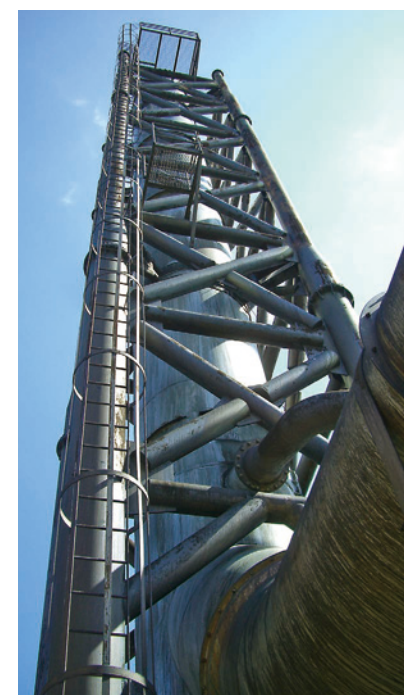
発電所の煙突
